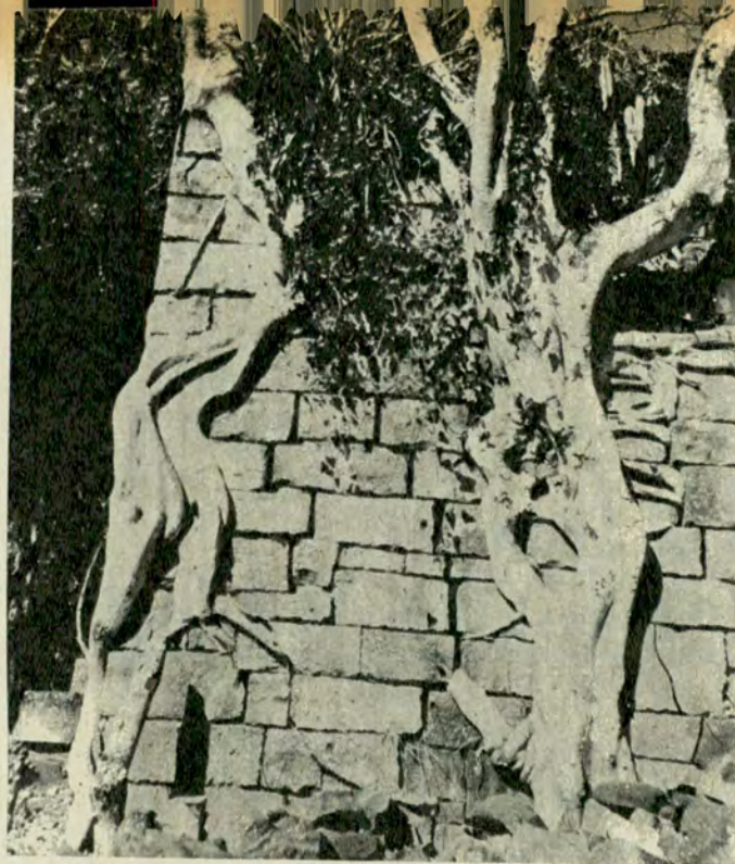
La selva invasora puede más que la piedra. Las plantas hunden sus tentáculos en los muros hasta derribarlos.
